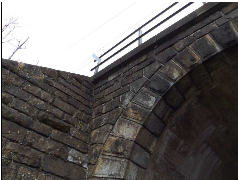
Obr. č. 10 - pohled na betonové „prefabrikáty“ vybrané římsy objektu
