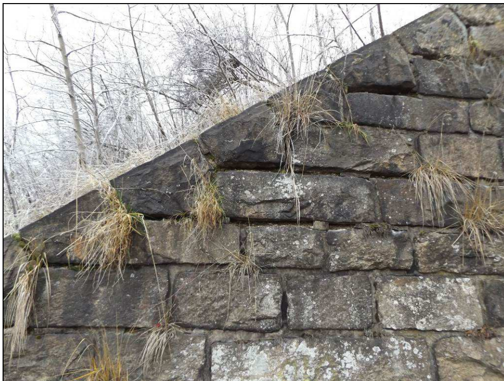
Obr. č. 9 - detailní pohled na vypadané vyspárování a rozvolněné kamenivo ve svrchní části vybraného křídla objektu
