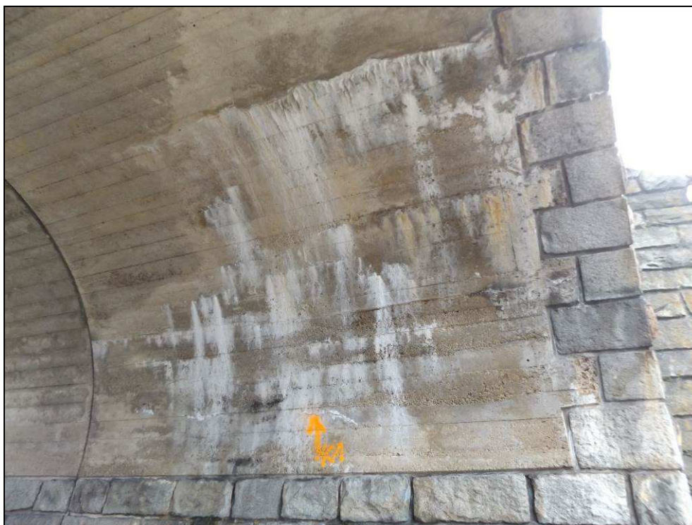
Obr. č. 7 - detailní pohled na průsaky nosnou konstrukcí objektu
